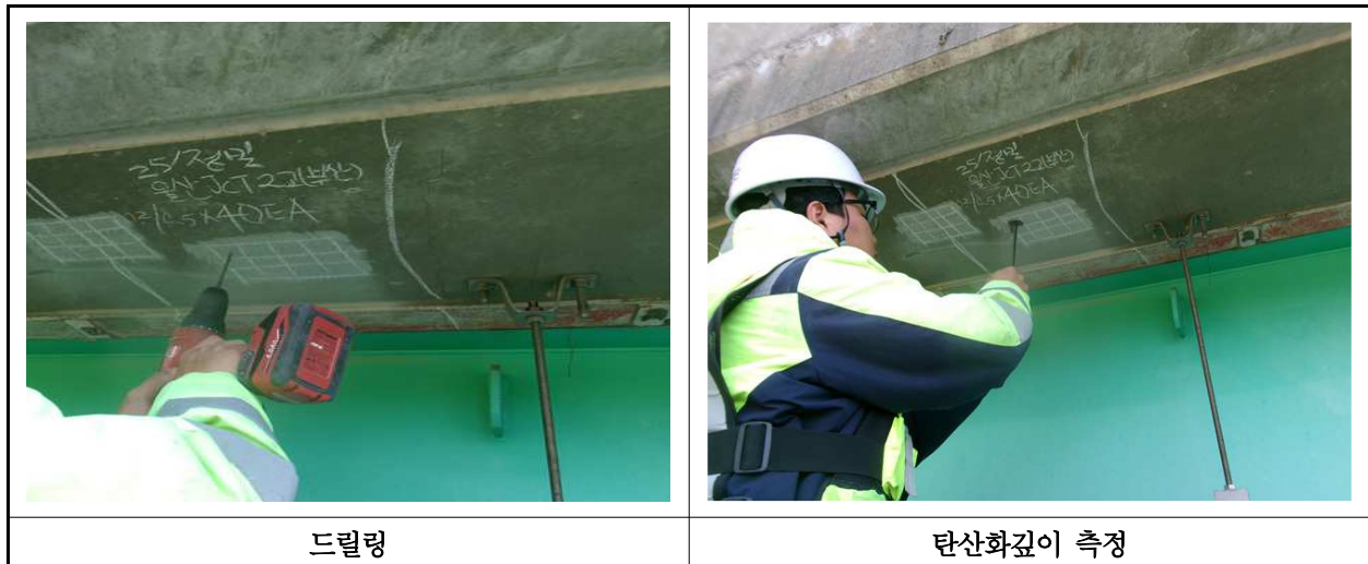
【사진 31.4.3】 탄산화 깊이 측정 현장사진
