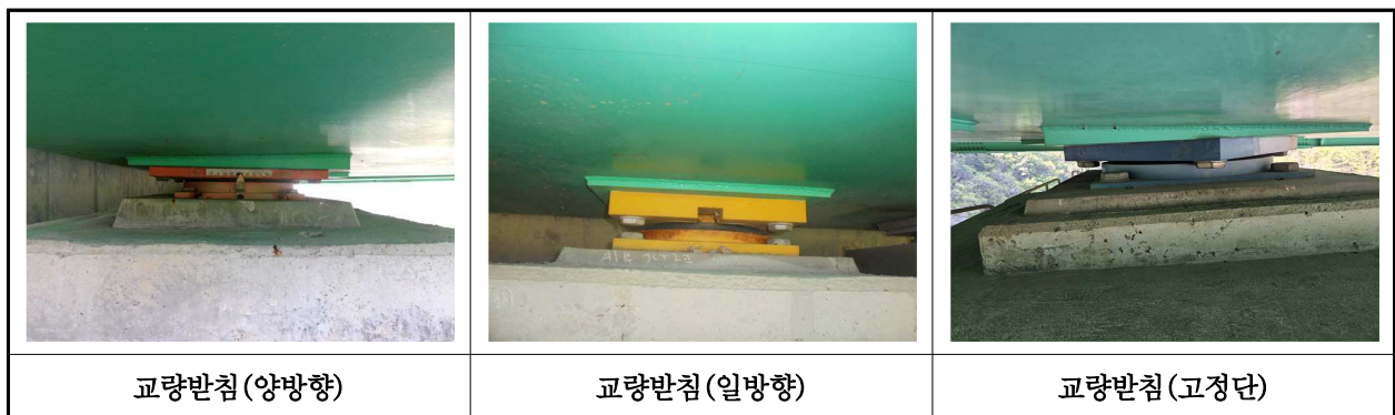
【사진 31.3.13】 교량반침 전경
