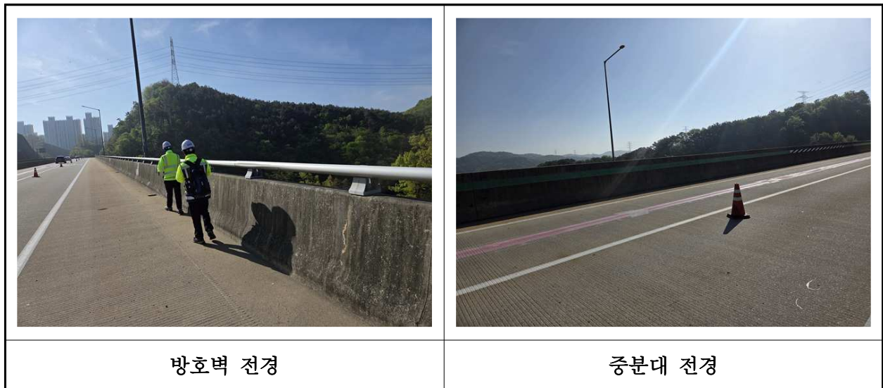
【사진 31.3.24】 방호벽 및 중분대 전경
