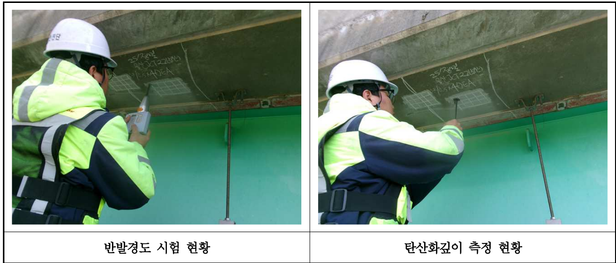
【사진 31.4.1】 콘크리트 내구성조사 현황
