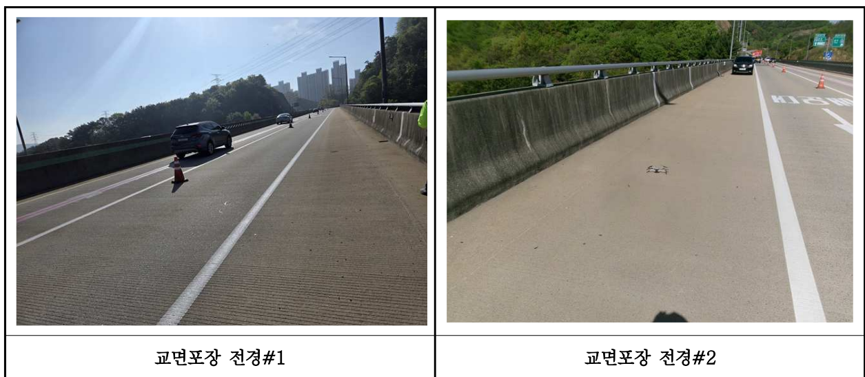
【사진 31.3.20】 교면포장 전경
