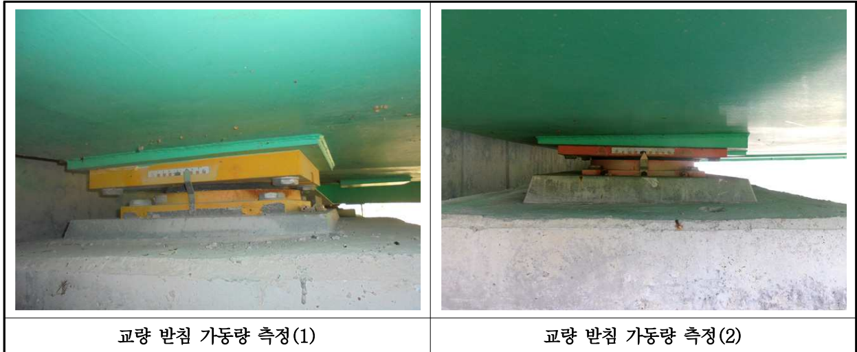
【사진 31.3.16】 교량받침 이동량 측정
