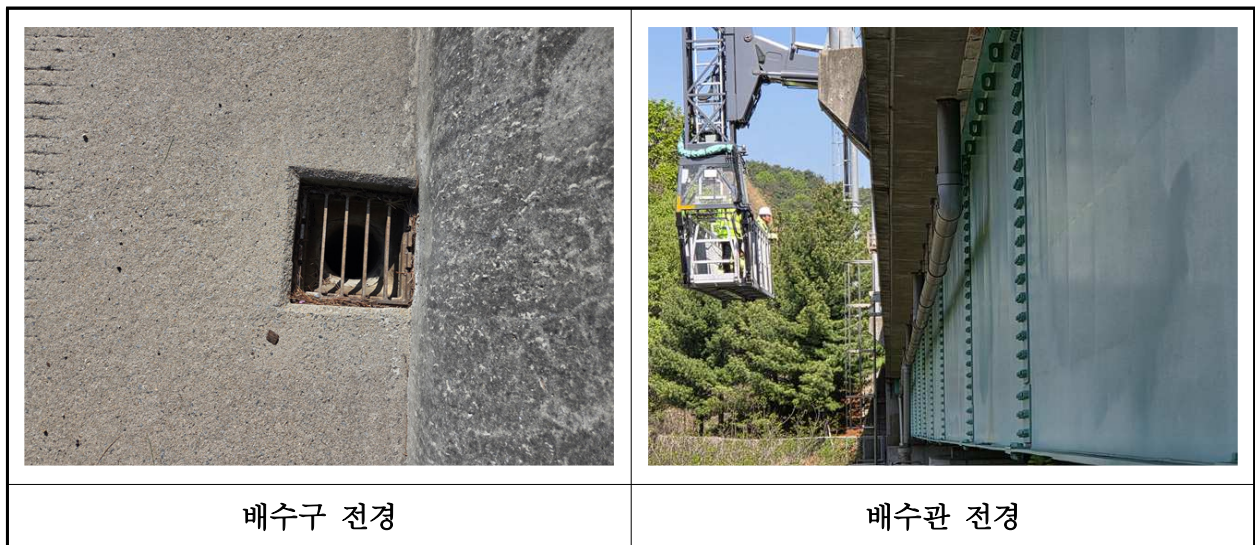
【사진 31.3.22】 배수시설 전경
