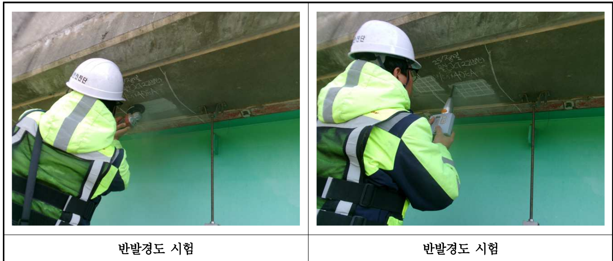
【사진 31.4.2】 반발경도시험 현장사진
