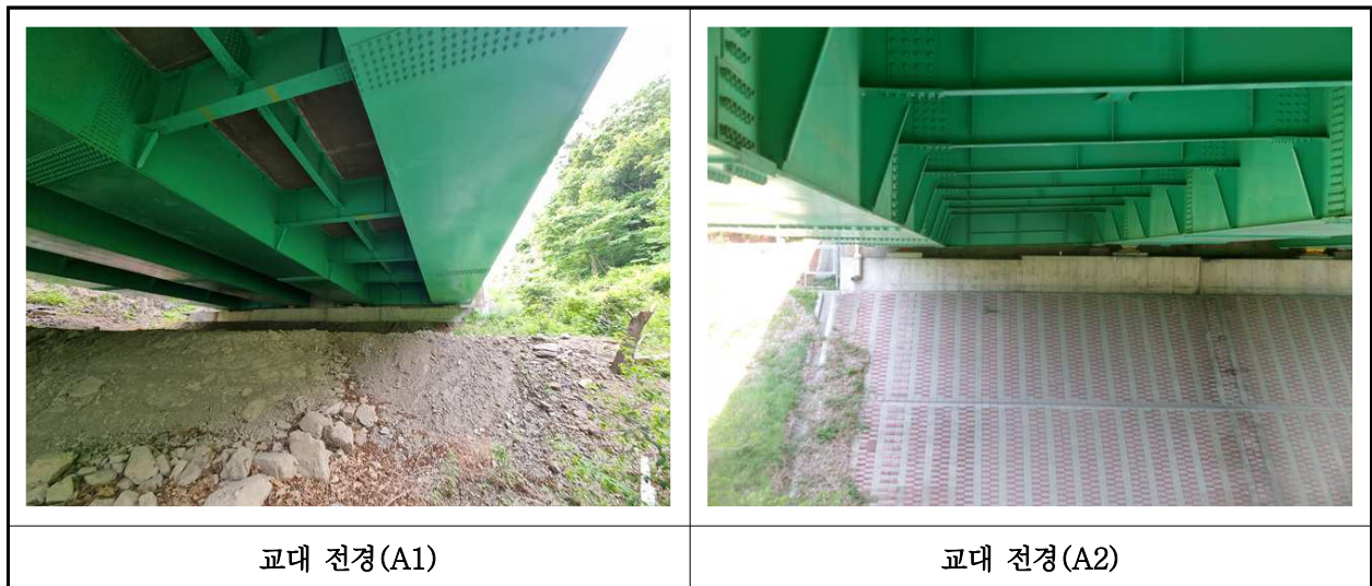
【사진 31.3.8】 교대 전경
