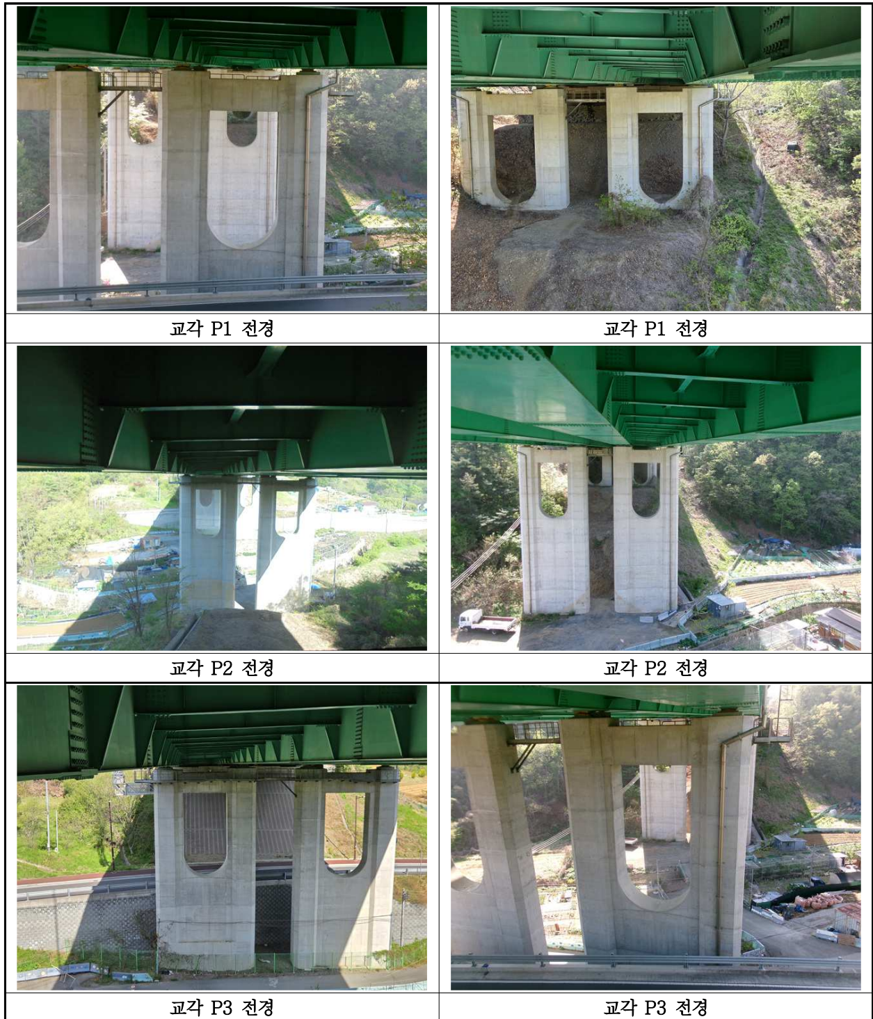
【사진 31.3.10】 교각 전경
